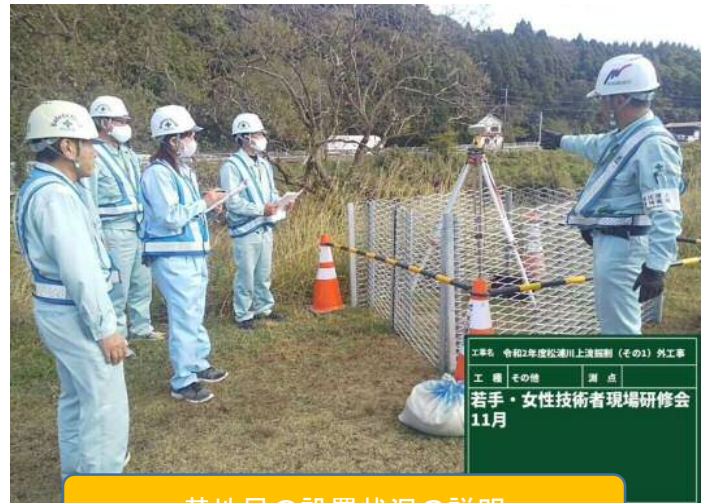
基地局の設置状況の説明
